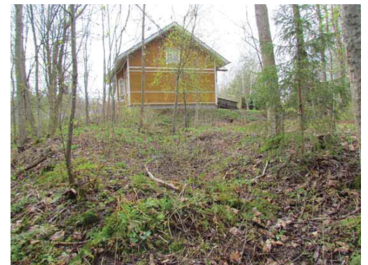
Kuva 10. Asuinrakennuksen luoteispuolella sijaitsevaa linnoitetta. Rakennus on rakennettu vanhan juoksuhaudan päälle ja linnoite lienee tuhoutunut rakennuksen alla ja pihapiirissä. Kuva: Kalle Luoto.
